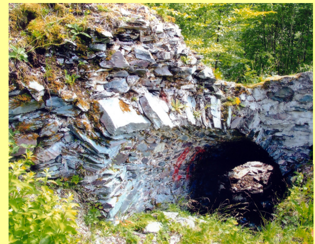
Gewölbereste eines Treppenaufgangs 2007
